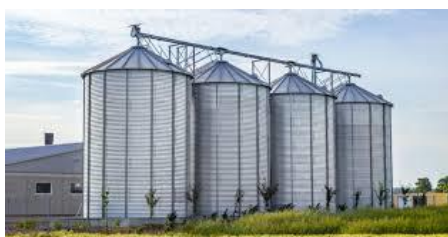
Figura 3: Exemplo de silo
